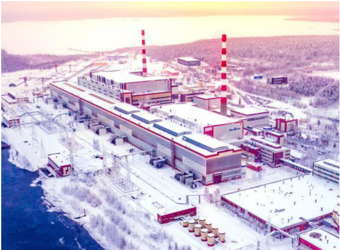
Рисунок 1.1 – Общий вид Кольской АЭС
